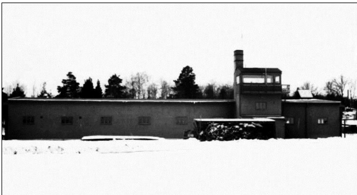
Byggnad 198 (Fälthangaren) med trafikledartorn.
